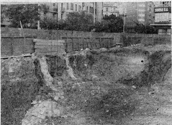
Las obras de la nueva sede del INP dieron comienzo en junio, quedaron paralizadas en Sanfermines y ahora ha comenzado, en serio, la excavación del solar. Las máquinas arrancaron muchos metros cúbicos de tierra y tufa. Por debajo tierra van a plantar de semisótano y tres plantas de sótano. Más de doce metros de excavación. — (Foto MENA).
